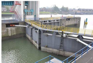
Figure 17 : Exemple de porte busquée (Barrage mobile dans le Hollandsche IJssel)
