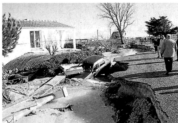
Février 2010 aux Moutiers-en-Retz : sous l'assaut des vagues, la route qui mène à la pointe du Collet cède, emportant voiture, poteaux et clôtures.
